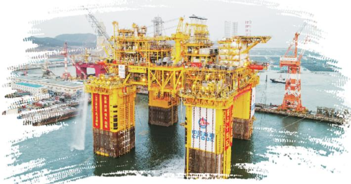
大投影面积相当于两个标准足球场大小,总高度达120米,相当于40层楼高,最大排水量达11万吨,相当于3艘中型航母。”据中国海油陵水17-2气田开发项目总经理尤学刚介绍,“深海一号”项目在建造阶段实现了
