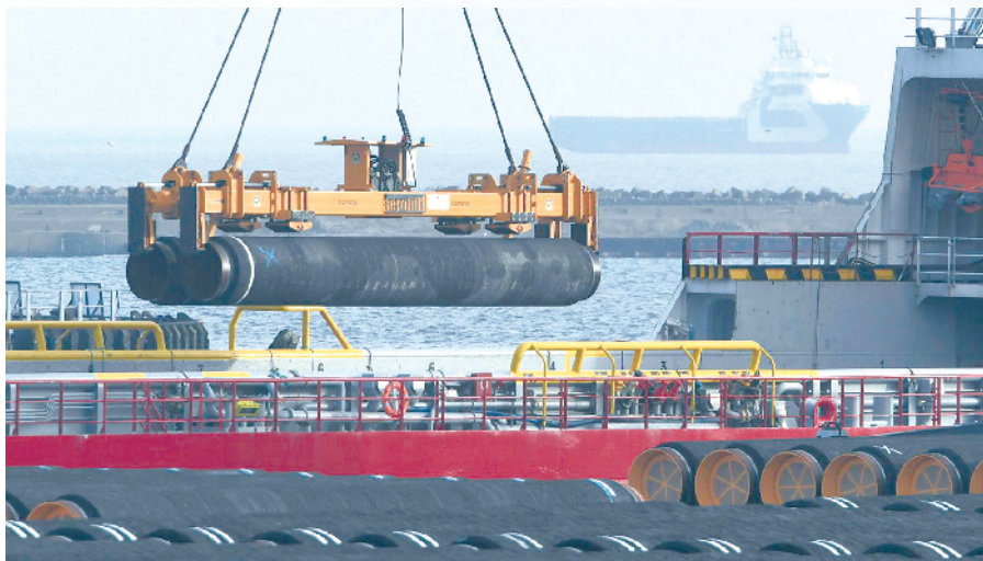
已运抵波罗的海穆克伦港口的“北溪 2 号”项目专用管道。 法新社/图
