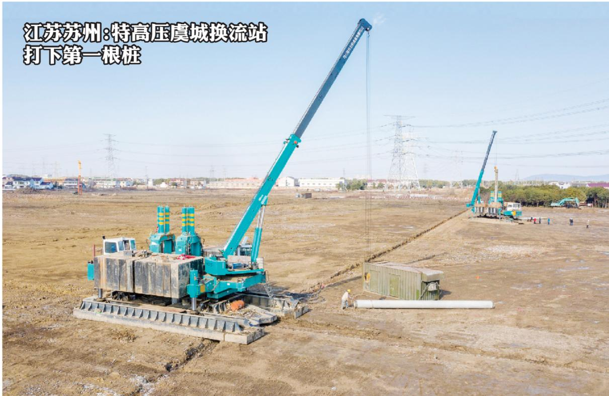
2020年12月30日,在白鹤滩—江苏±800千伏特高压直流输电工程虞城换流站现场,施工人员操作大型静压机打下第一根桩。该工程为世界首座特高压混合级联柔性直流换流站,对于优化配置西南水电资源,满足江苏快速增长的负荷需求,提升电力发展水平以及促进经济社会发展具有重要意义。
