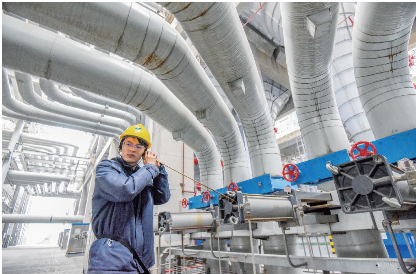
图为日前工作人员在湖北华电江陵发电有限公司生产车间“听诊”，检查设备运行情况。CFP/供图
