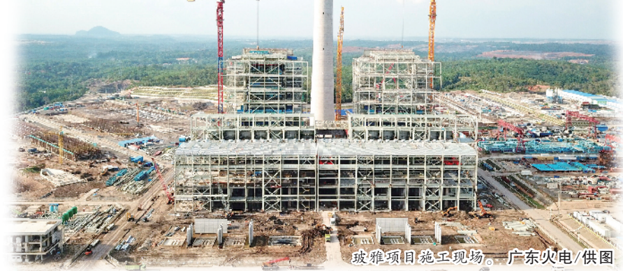
玻雅项目施工现场。广东火电/供图
