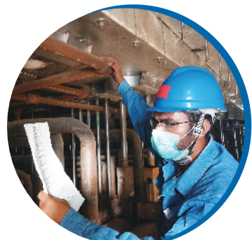
阿迪尔检查项目1号余热锅炉管排及吊装安装质量。江苏电建一公司/供图
