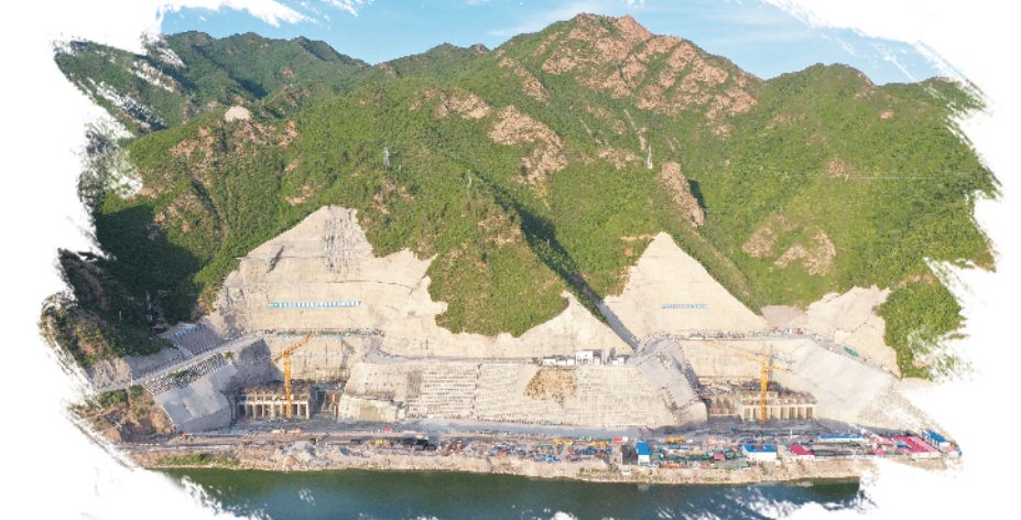
丰宁抽水蓄能电站下水库进出水口施工现场。郑江/摄
