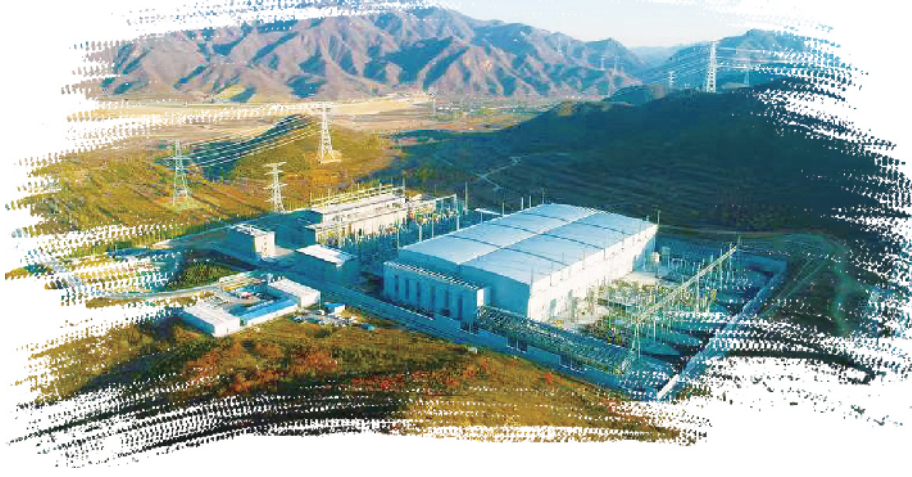
张北柔性直流电网试验示范工程北京换流站
