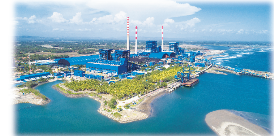
芝拉扎三期项目全景图。浙江火电/供图
