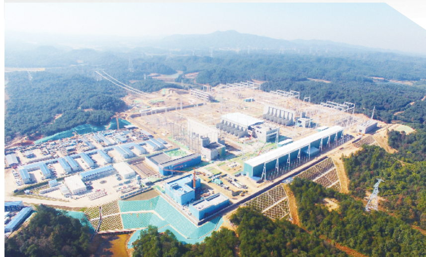
2020年11月11日,南昌±800千伏换流站建设现场。肖森华/摄
