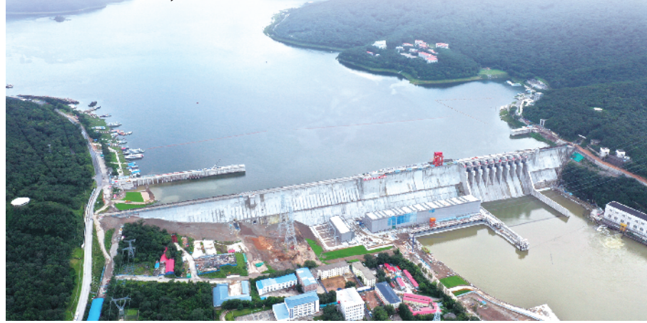
丰满水电站全景。张强/摄
