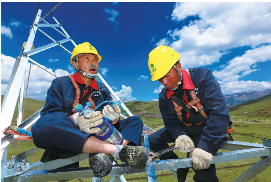
国网四川电力人员在四川省甘孜藏族自治州理塘县进行电网建设,由于海拔高,氧气稀薄,高空作业时需在塔上吸氧。 田海/摄
