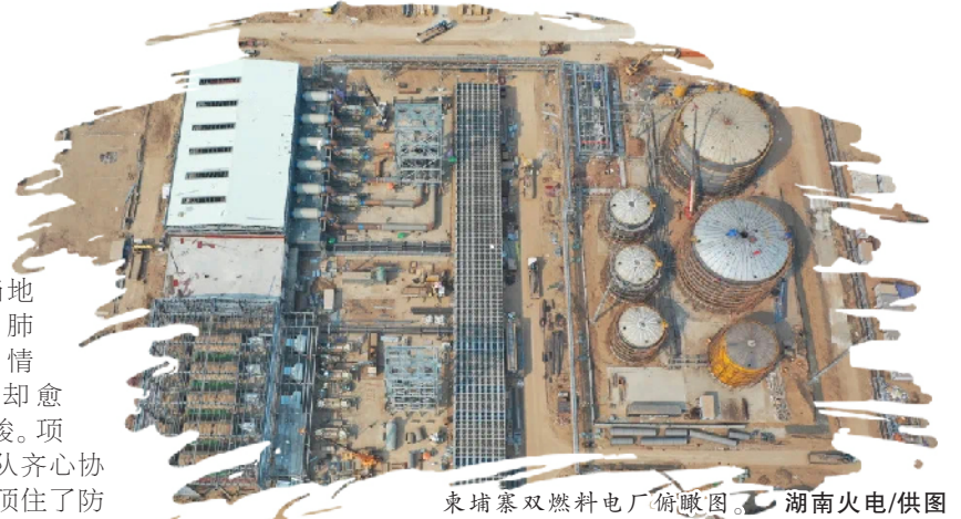
柬埔寨双燃料电厂俯瞰图。湖南火电/供图
