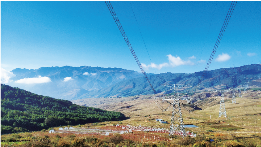
锦屏-苏南特高压直流输电工程。 王志川/摄
