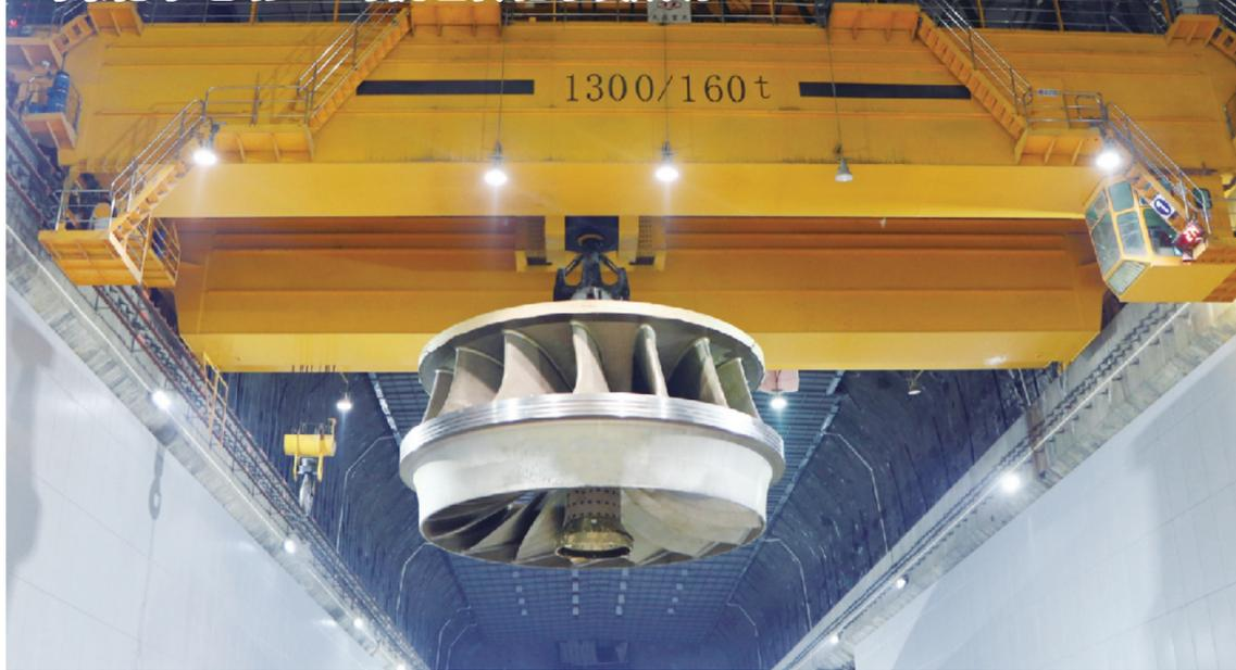
8月25日16时，乌东德水电站10号机组转轮吊装成功，为按期发电奠定了坚实基础。
