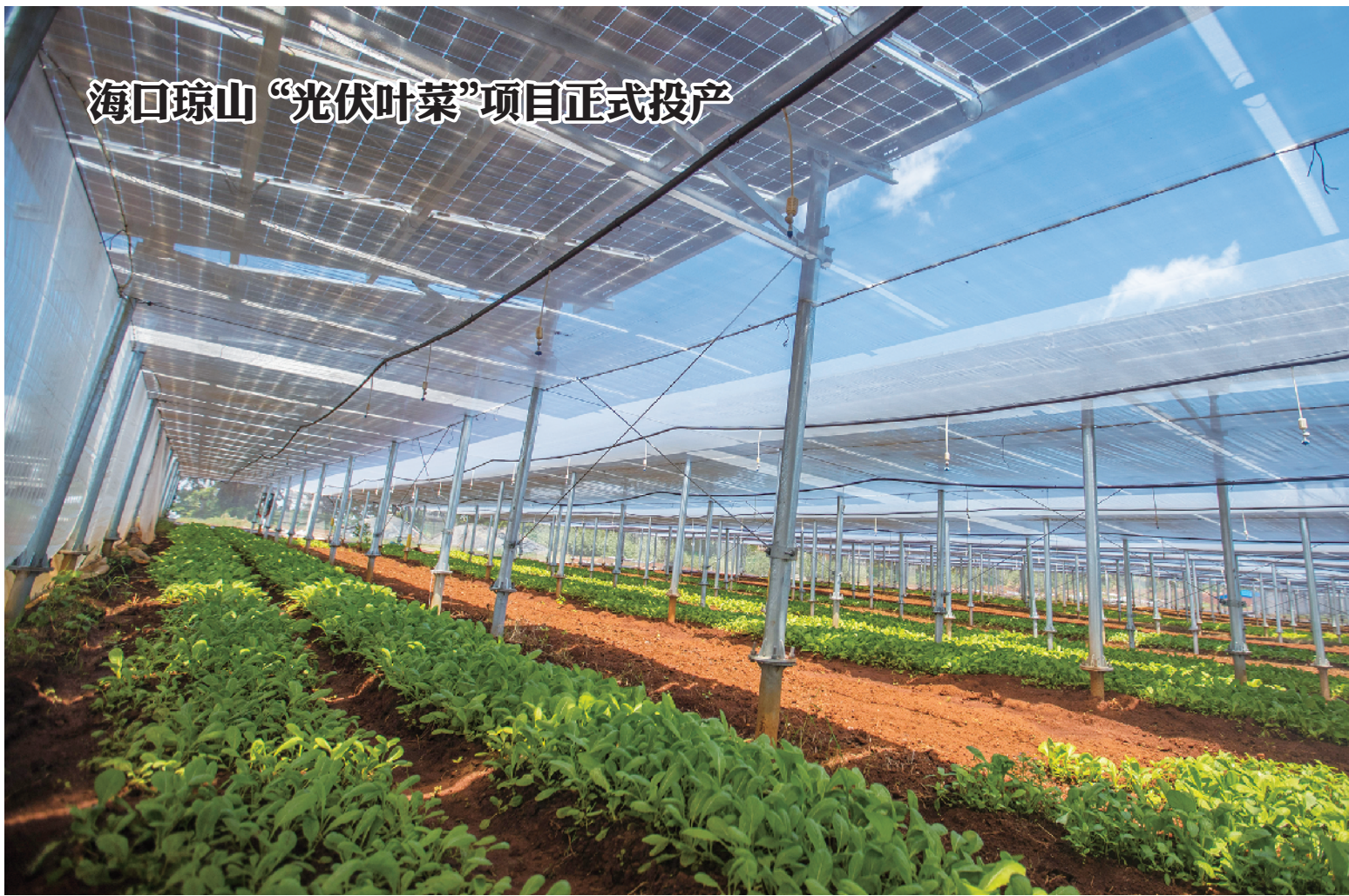
海南省海口市琼山区甲子镇福昌村,300兆瓦农光互补项目日前投产。该项目总投资20亿元,整个项目面积约为6000亩,可为周边村庄提供就业岗位300多个。人民图片
