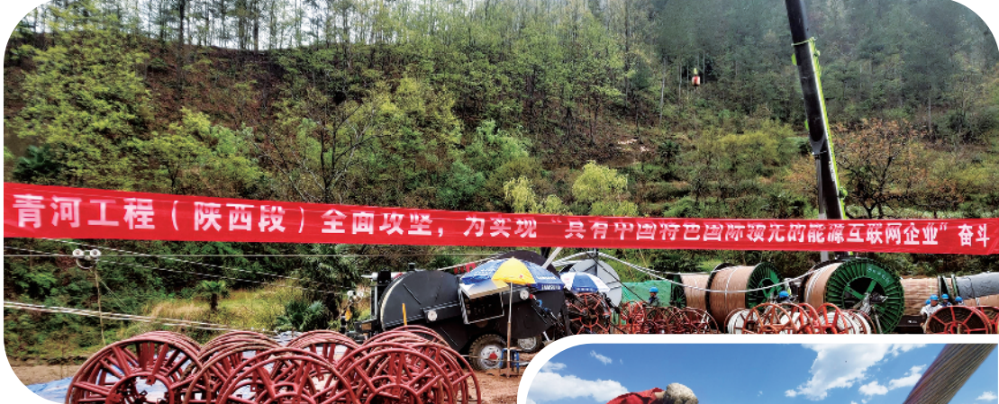
秦岭陕湖特高压工程建设复工 国网陕西电力/供图
