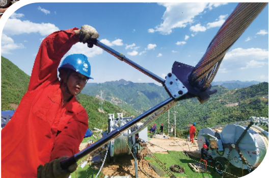
青河工程放线施工现场 刘军峰/摄
