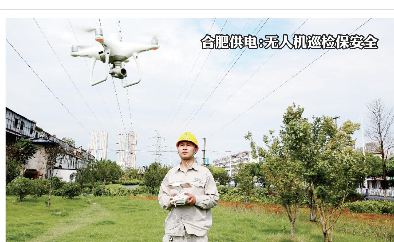
8月13日上午10时,在位于安徽省合肥市瑶海区新安江路的220千伏合螺线下方,合肥供电公司输电运检中心人员熟练操控着无人机,对输电通道进行特巡,保障电网安全。在操控人员手持终端屏幕上,清晰呈现出几十米高空中的线路图像。
