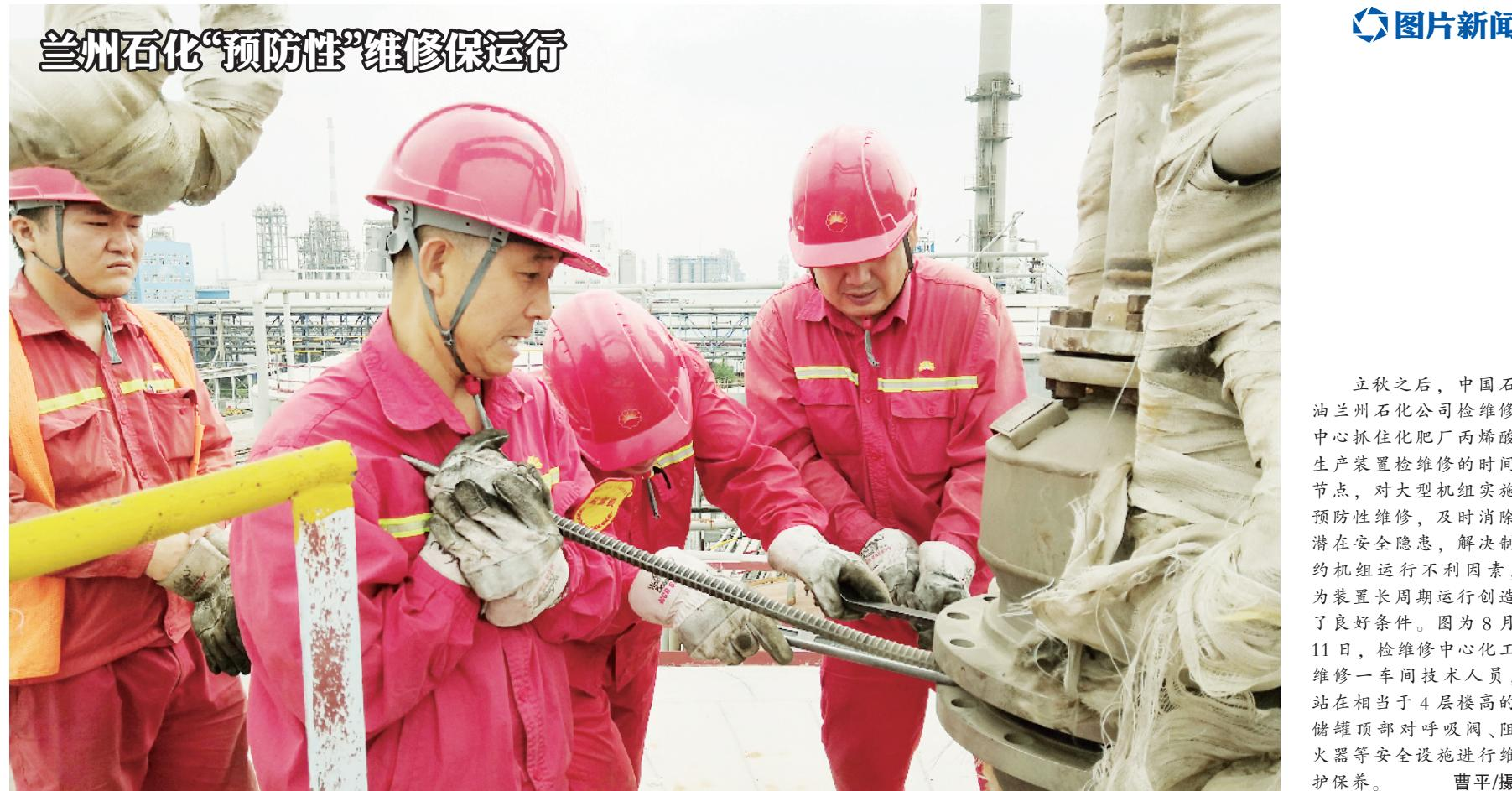
立秋之后，中国石油兰州石化公司检维修中心抓住化肥厂丙烯酸生产装置检修维修的时间节点，对大型机组实施预防性维修，及时消除潜在安全隐患，解决制约机组运行不利因素，为装置长周期运行创造了良好条件。图为8月11日，检维修中心化工维修一车间技术人员，站在相当于4层楼高的储罐顶部对呼吸阀、阻火器等安全设施进行维护保养。曹平/摄
