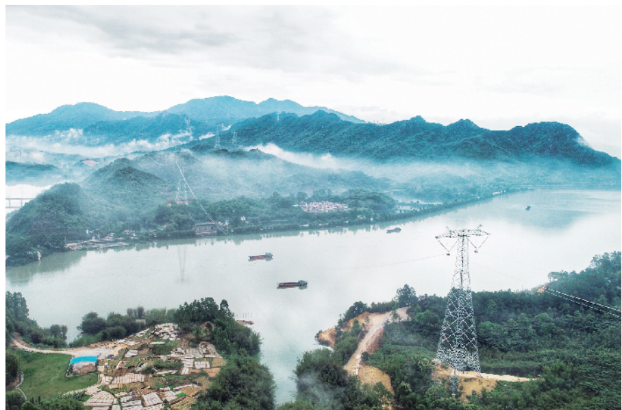
昆柳龙直流工程广东段跨越北江线路。 李志杰/摄
