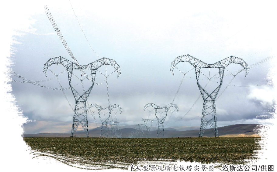
羊头型景观输电铁塔实景图/洛斯塔公司/供图
