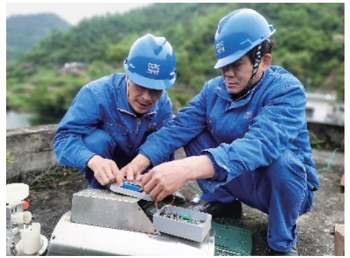
葛洲坝机电公司南河公司员工维护雨量站设备 葛洲坝集团/供图
