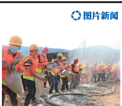
葛洲坝集团山西高速项目公司员工加固围堰 葛洲坝集团/供图
