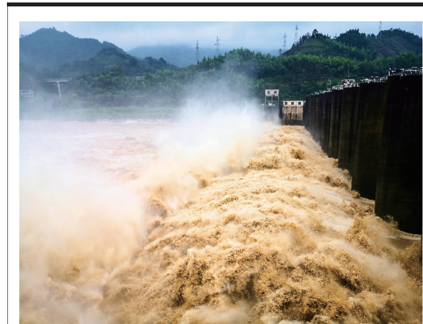
广西水电集团龙江下桥水电站开闸泄洪 李德颖/摄
