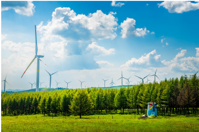
7月30日,在河北省承德市围场满族蒙古族自治县,一台台风力发电机迎风旋转,源源不断地输送绿色电能。 人民图片
