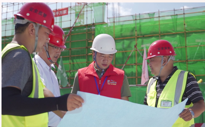
绵阳市涪城区产业链项目专员现场查看项目推进进度。
