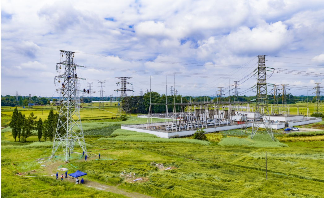
4月15日，在四川大邑县苏场220千伏变电站外，电力工人在开展110千伏高塔-苏场新建线路工程5号塔放线工作。 人民图片
