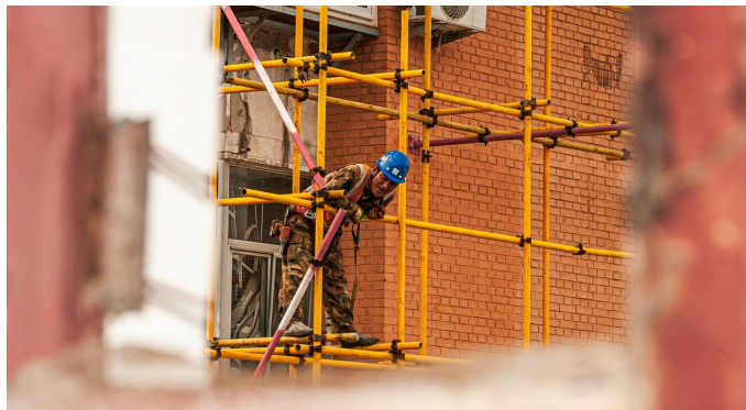
北京朝阳管庄东里社区旧楼已经朽坏的木窗框外，工人正在加紧进行样板楼施工。
