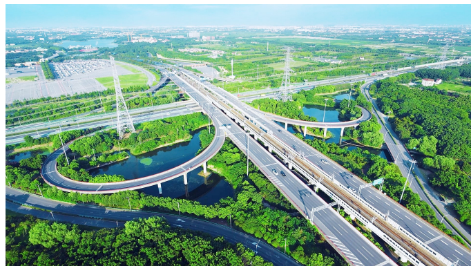
上海市浦东新区康桥镇桥梁飞架、路网交错，编织着城市的发展脉络。 康桥镇人民政府供图
