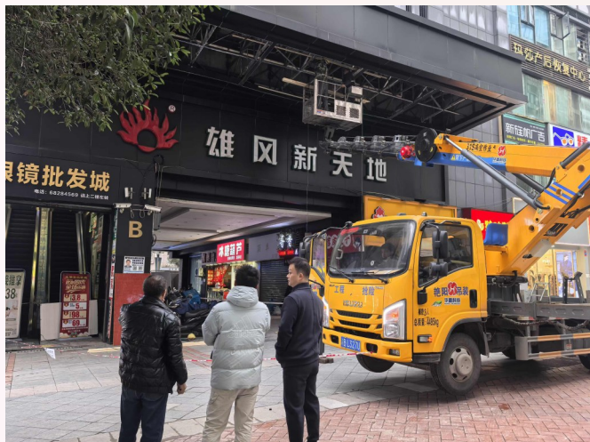
重庆市北碚区北温泉街道在雄风新天地商场门口排危应急处置。
