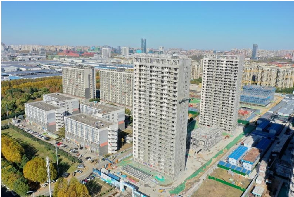
位于安徽省合肥高新区柏堰湾路与南台山路交口的保障性租赁住房一期，已完成全部结构验收，正在进行室内精装修及安装施工，预计2025年5月竣工，可提供400套住房。
