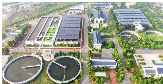
近年来,江苏省连云港市大力推进核能、氢能、光能、风能、储能开发,加快新能源基础设施网络建设,着力构建清洁低碳、安全高效的现代能源体系。图为在江苏连云港高新区海州工业园拍摄的企业屋顶光伏发电设备。中新社发 耿玉和摄
