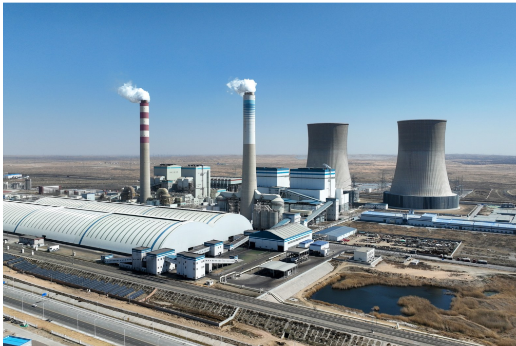
宁夏作为我国“西电东送”战略的重要送端,拥有丰富的煤炭、太阳能、风能资源。通过宁夏至山东、宁夏至浙江两条电力外送通道,将“风光火”能源打捆外送,形成东西互济、内消外送、多能融合的能源大基地格局,在保障能源安全的同时,助力国家实现“双碳”目标。图为宁夏回族自治区灵武市境内戈壁滩上矗立的发电厂区。
