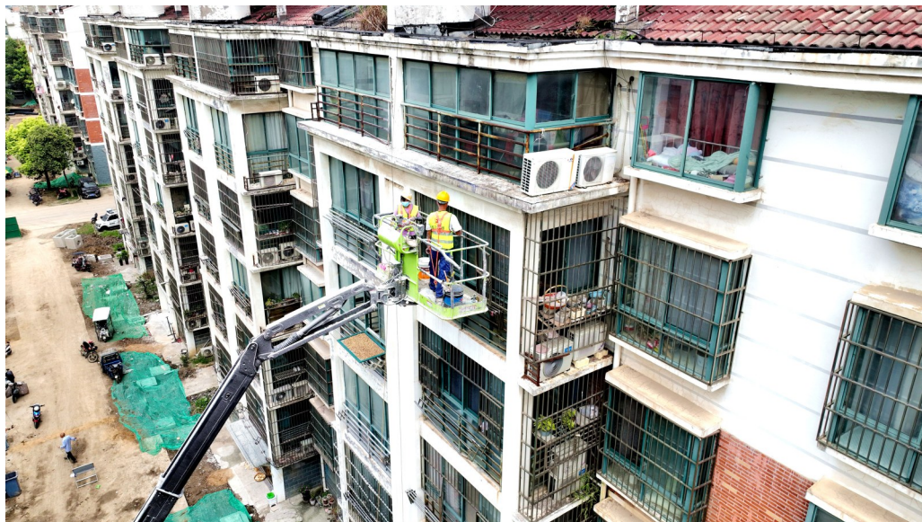
今年，江苏省宿迁市泗洪县对金色家园小区等8个老旧小区进行改造，计划投入资金1.76亿元，涉及楼栋291栋、建筑面积93.7万平方米，惠及居民10052户。图为泗洪县学府文苑小区正在进行修缮更新改造。 人民图片
