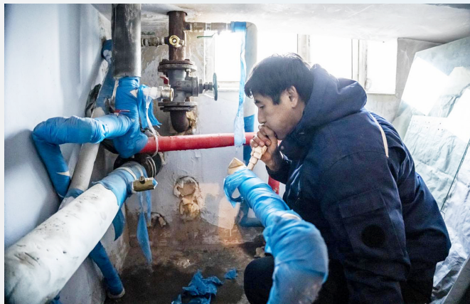
黑龙江省大兴安岭地区德净供水有限责任公司组织党员为居民抢修冻裂自来水管。
