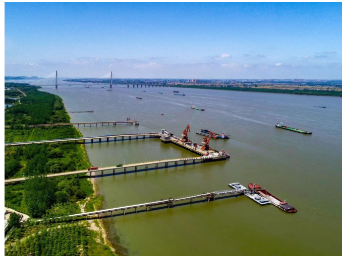
安徽省池州市东至县经开区码头运输作业场景。徐永才摄
