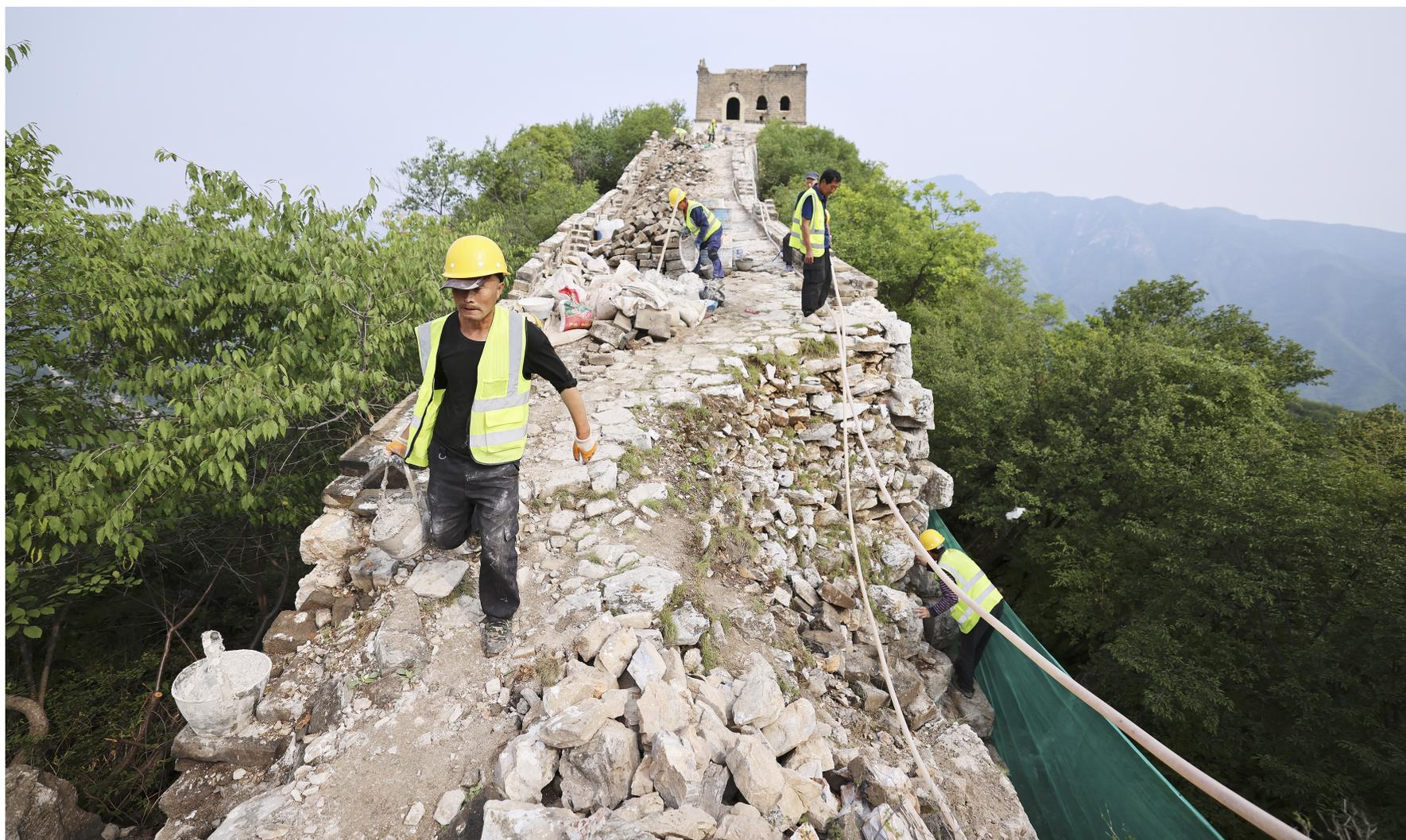
近日,位于北京怀柔的箭扣长城第五期保护修缮项目启动,修缮从正北楼起向慕田峪景区方向共涉及6座敌台,总长度915米,修缮工期将持续三年。这期修缮实现了“边考古,边修缮”的无缝衔接,在确保长城本体安全的前提下,尽可能做到最小干预,保持原有的风貌。图为工匠在长城正北楼段运送石灰砂浆。
