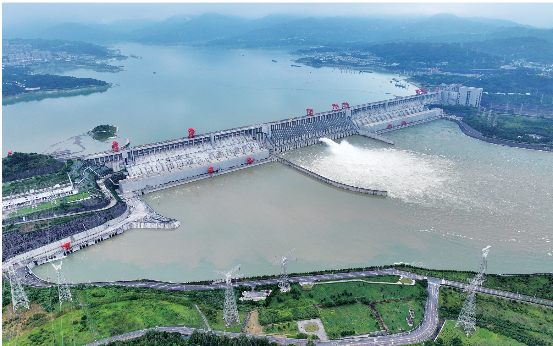
长江上游迎来多次涨水过程，水利部长江水利委员会调度三峡水库分别于7月10日14时、18时各开启1个泄洪孔，出库流量由27000立方米每秒逐步增加至31000立方米每秒，在洪峰来临前控制三峡水库水位，为拦洪削峰做好准备。图为三峡水库今年首次开闸泄洪。 中新社发 王 昱摄
