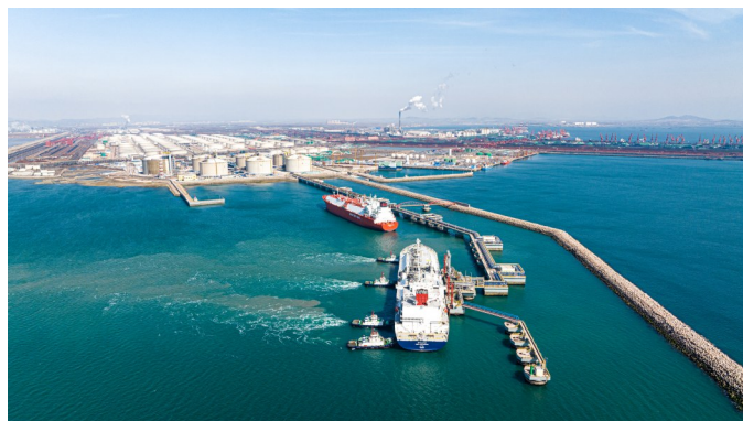
中国石化青岛LNG接收站。
