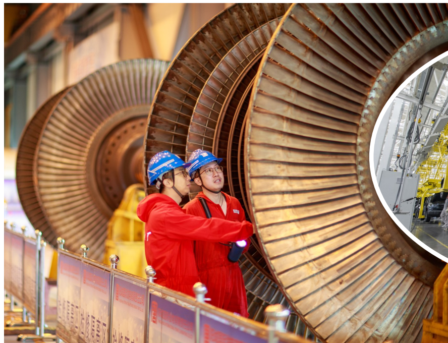
5月23日,山西省阳城电厂汽机班工人在检查汽轮机转子叶片运行情况。
