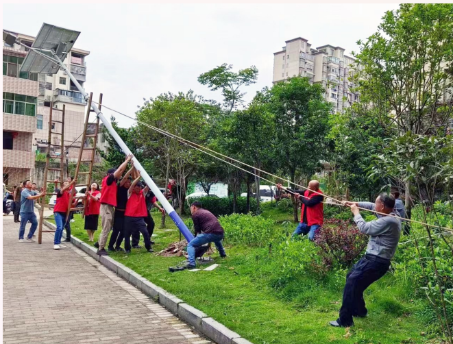
抚州市宜黄县结对共建单位帮助挂点小区安装路灯。
