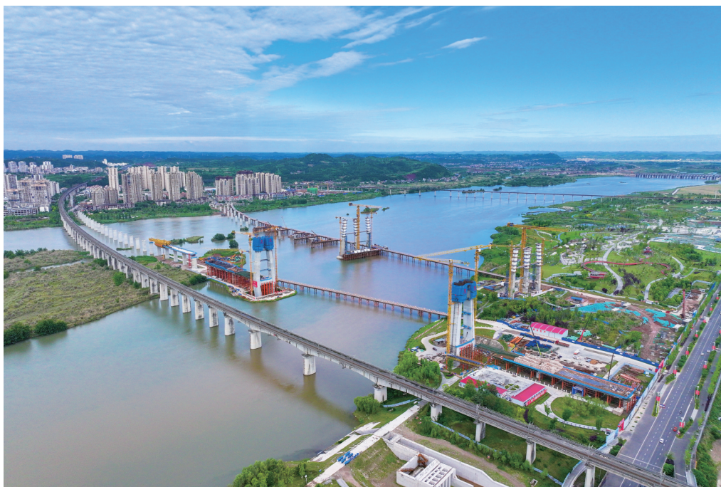
这个“五一”假期,四川成都经达州至重庆万州高速铁路(以下简称“成达万高铁”)遂宁涪江特大桥建设现场如平常一样热火朝天。作为全线控制性工程,涪江特大桥已完成进度的40%,比预计工期提前了3个月。图为工人师傅正在成达万高铁遂宁涪江特大桥上进行钢筋作业。
