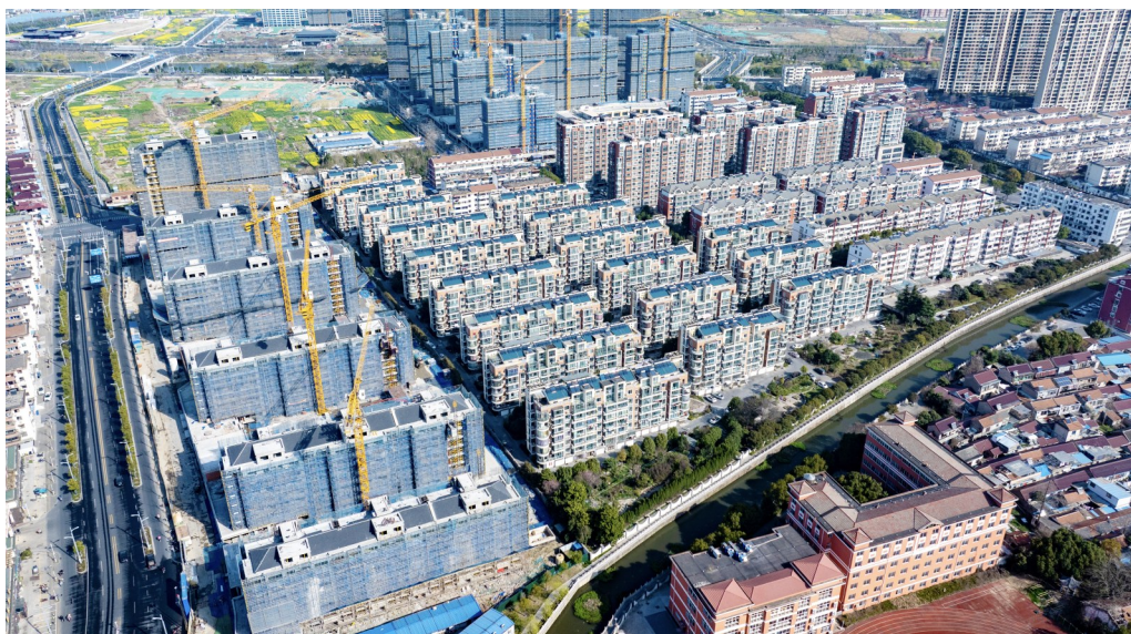
近年来,江苏省海安市把住房保障作为重要的民生工程、民心工程来抓,积极实施保障性住房、人才公寓、青年公寓等项目建设,不断提升保障房建设品质,改善人居环境,让更多市民早日实现高品质幸福“安居梦”。图为3月22日,位于海安高新区的雅仕书苑保障性住房工程正在加紧施工。
