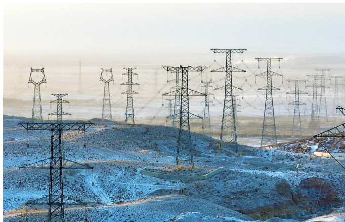
宁夏回族自治区灵武市戈壁荒滩上的太阳能光伏和风力电站与白雪交相辉映，源源不断地输送着绿色电能。宁夏回族自治区作为我国“西电东送”战略的重要送端，拥有丰富的煤炭、太阳能、风能资源。截至1月18日，宁夏累计外送电力突破7000亿千瓦时。
