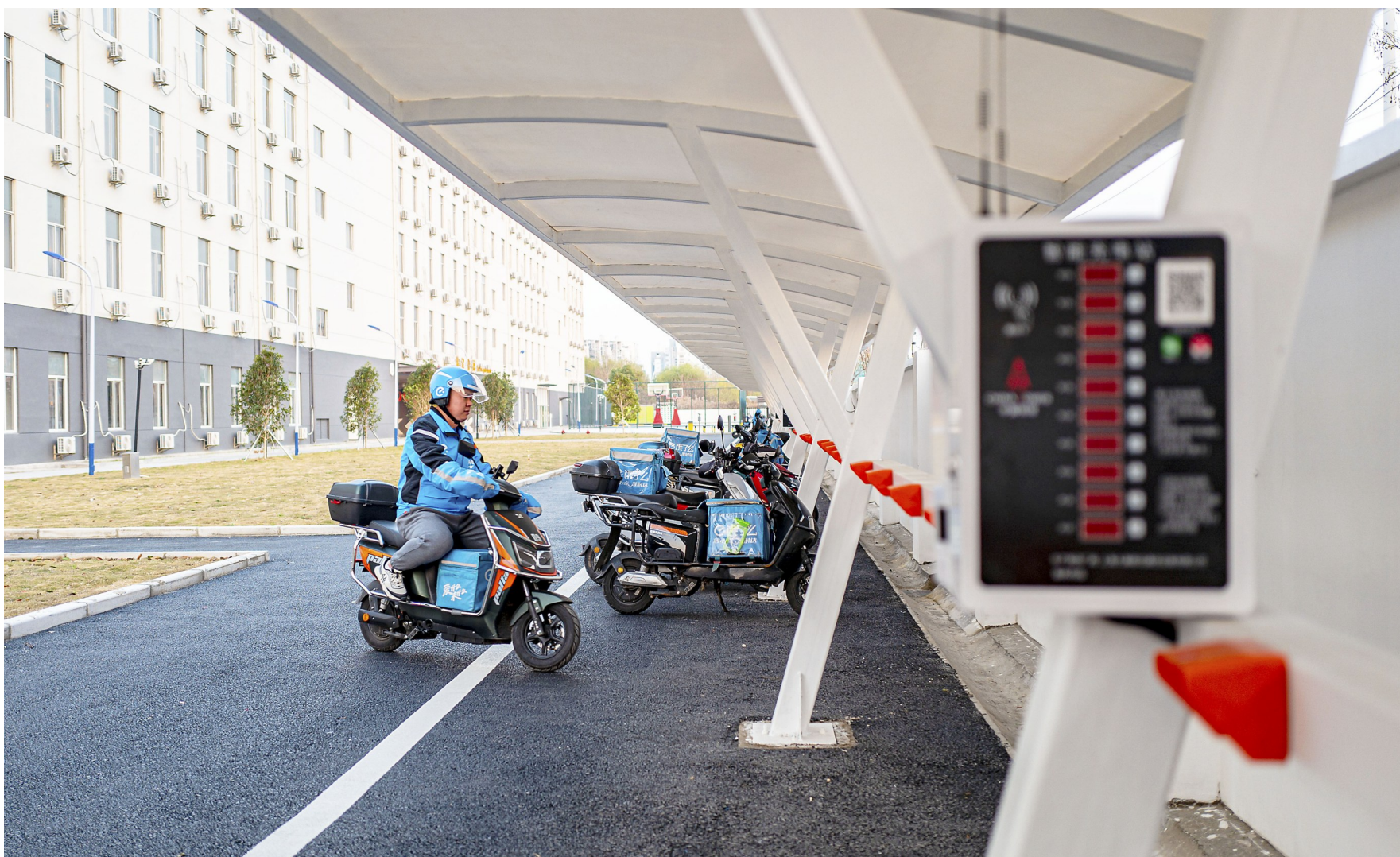
近年来,上海市加大保障性租赁住房筹措建设力度,着力构建“一张床、一间房、一套房”多层次租赁住房供应体系,让更多群众安居乐业。近日,位于上海市普陀区桃浦镇武威东路718号的和欣公寓“新时代城市建设者管理者之家”敞开大门,欢迎首批外卖和快递骑手入住“骑手之家”。和欣公寓紧邻中环,是一个由闲置厂房改建的保障性租赁住房项目,建筑面积约1.6万平方米,拥有550间宿舍型租赁住房。图为和欣公寓“骑手之家”设置了公共充电桩,方便骑手为电动自行车充电。 人民图片
