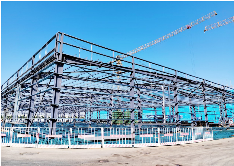
建设中的河南兴阳光电科技有限公司。李新摄
