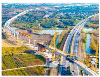
11月26日,上海市青浦区上海17号线西延伸工程正加紧建设。17号线西延伸项目由既有东方绿舟站向西延伸至在建西岑站,全长6.6公里,共设一站一区间,全线为高架线路,两站一体化设计,实现城市交通无缝换乘,是长三角一体化示范区内一条重要的轨道交通线路。
