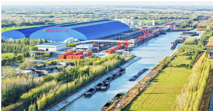
南水北调东线一期工程打通京杭大运河水上通道,让西煤东运“咽喉要地”的山东省济宁市梁山港,开启通江达海新征程。
