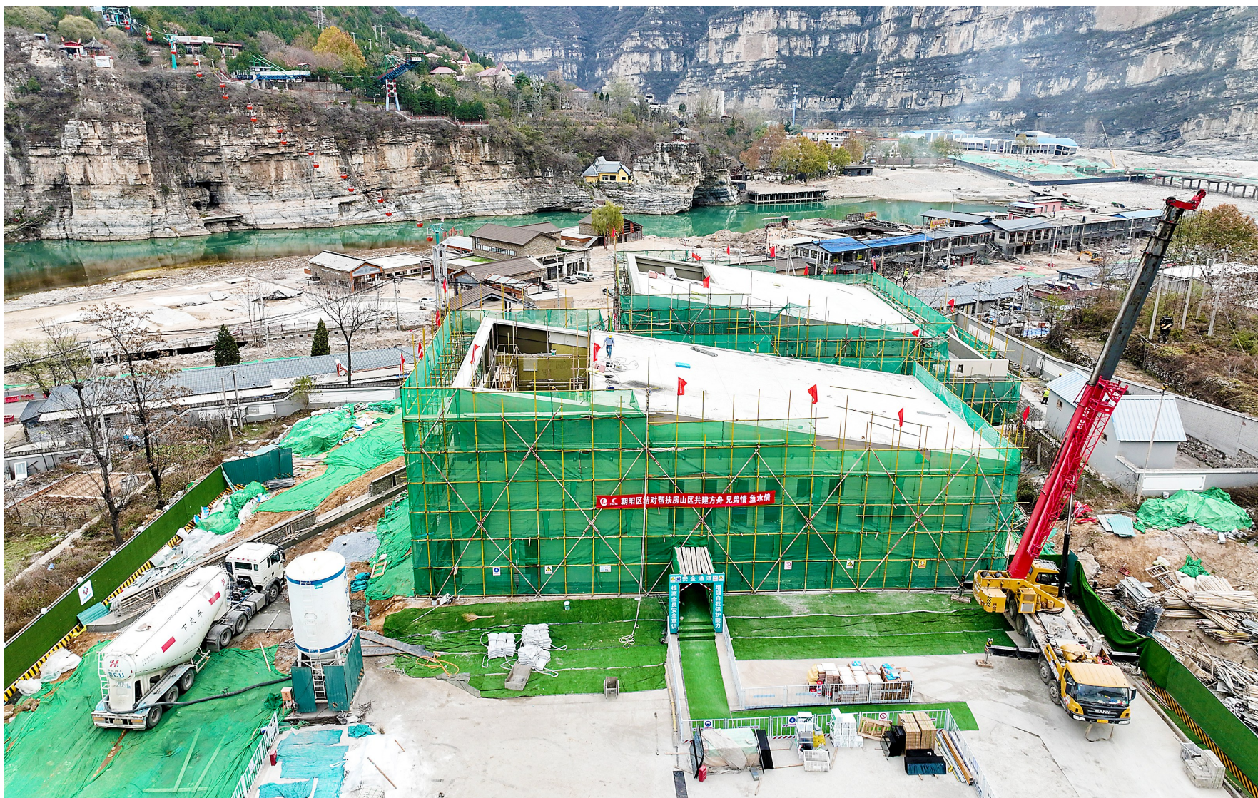
11月15日，北京市房山区十渡应急保障中心建设现场正有序施工。十渡应急保障中心为“平急两用”设施，平时作为十渡社区服务中心使用，应急时作为十渡应急保障中心使用，是北京市首个灾后新建公共服务设施项目。目前，该项目已完成二次结构施工，预计将于年底完工。 中新社记者 贾天勇摄
