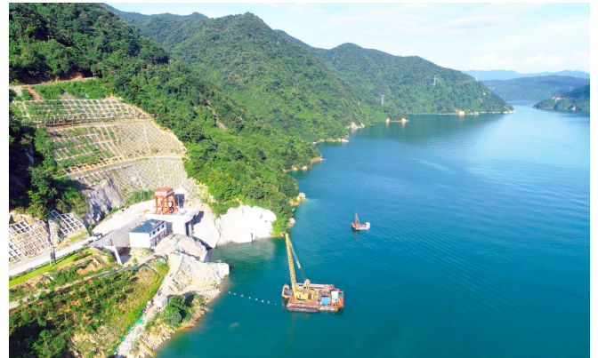
湖南省郴州市东江引水工程景观。郴州市水利局供图
