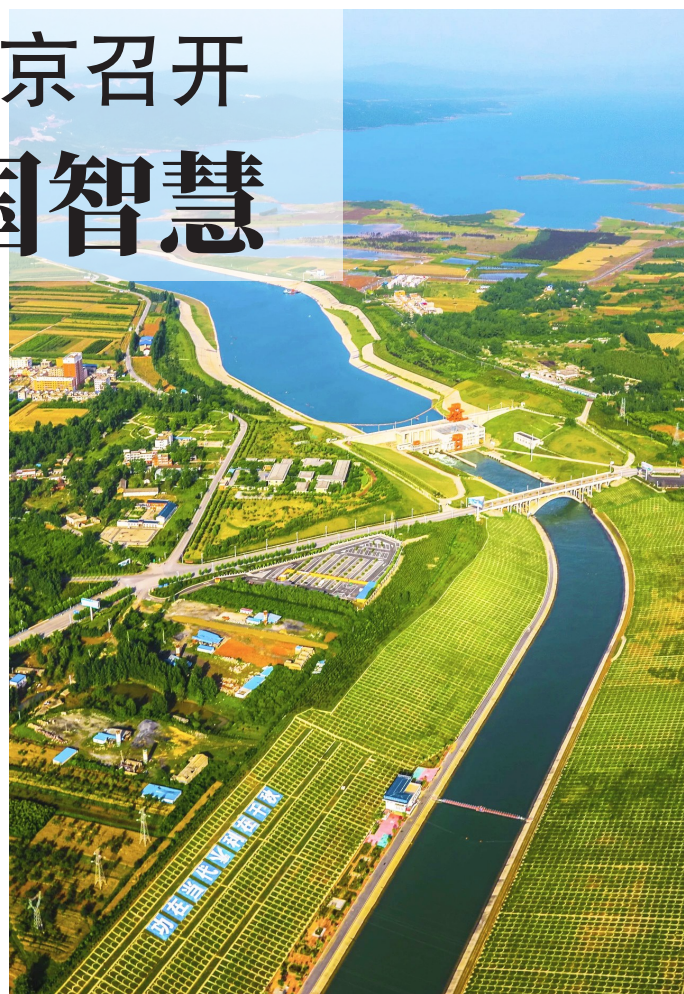
南水北调中线工程的“水龙头”陶岔渠首枢纽工程。 中国南水北调集团供图
