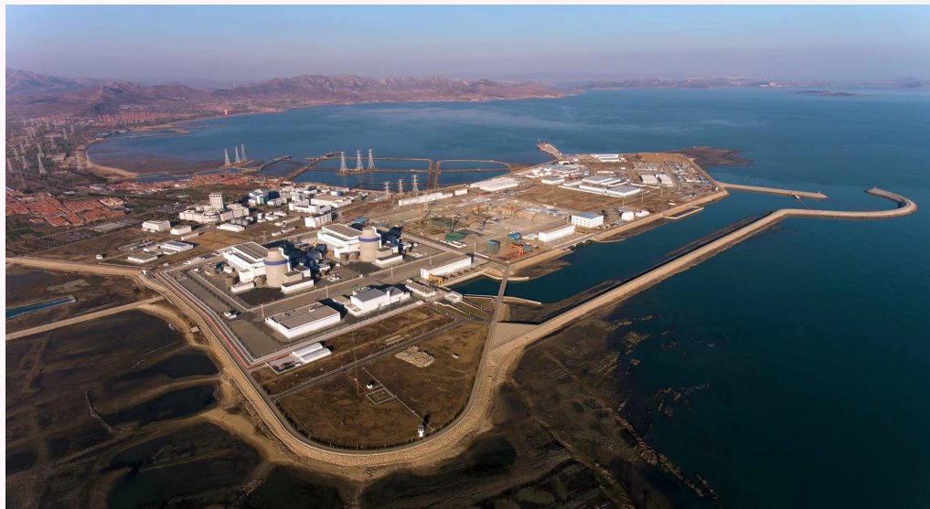
由烟台蓝天投资开发集团参与建设、全力支持配合的国家重点工程—海阳核电项目“暖核一号”三期核能供热长输管网工程开工。
