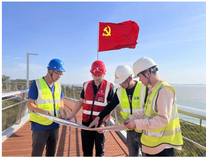
厦门市政集团有限公司党委在重点项目设立临时党支部，持续深化“支部建在项目上、党旗飘在工地上”。
